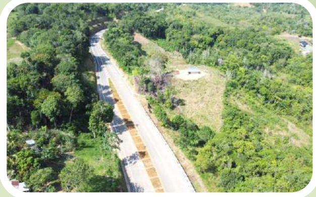
Pr. 48 Sector La Porquera - Zaragoza
