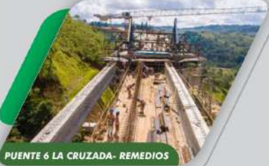
PUENTE 6 LA CRUZADA- REMEDIOS
