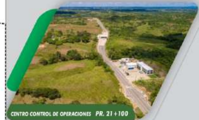
CENTRO CONTROL DE OPERACIONES PR. 21+100
