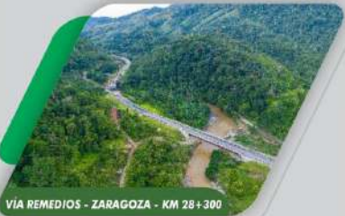
VÍA REMEDIOS - ZARAGOZA - KM 28+300
