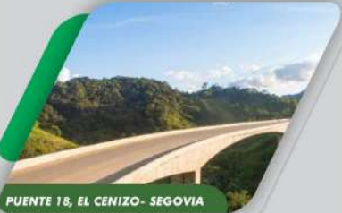
PUENTE 18, EL CENIZO- SEGOVIA
