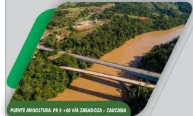
PUENTE ANGSTURA, PR 8 + 00 VÍA ZARAGOZA - CAUCASIA
