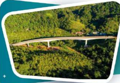
Puente 18, El Cenizo
