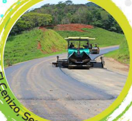
Instalación de carpeta asfáltica
