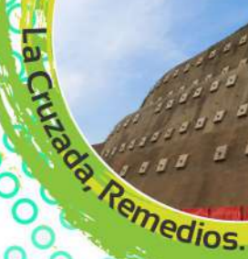
Estabilización de Taludes
