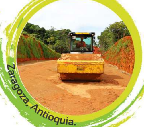
Proceso de compactación de material granular.
