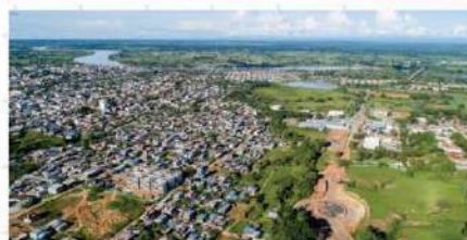
Construcción de la variante en Caucasia
