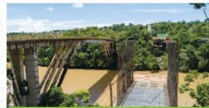
Construcción Puente de Angostura
