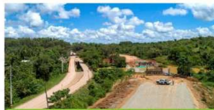
Construcción Puente Caceri Caucasia
