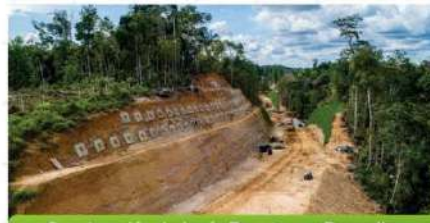
Construcción de la vía Zaragoza - Remedios
