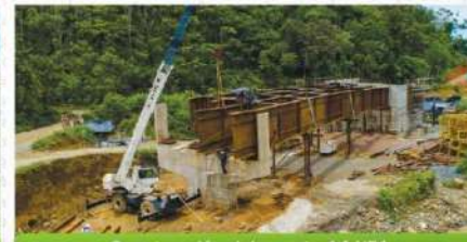
Construcción del puente 14 UF1
