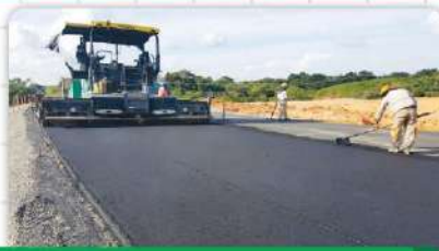
INSTALACIÓN DE MEZCLA ASFÁLTICA
