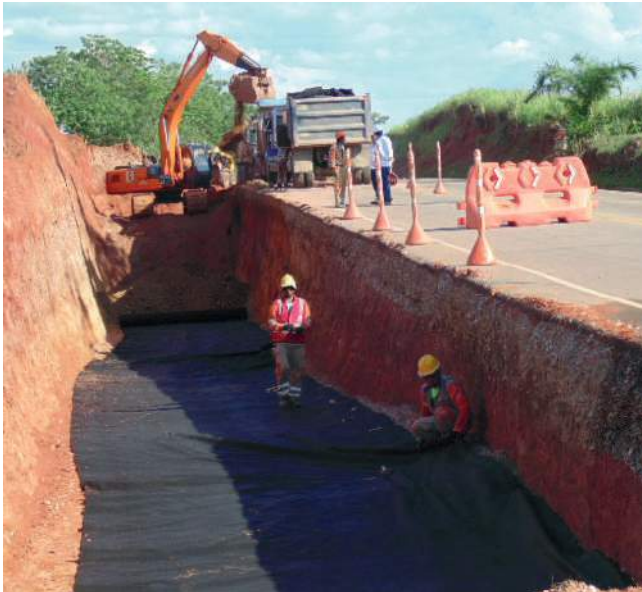
Mejoramiento de la subrasante
