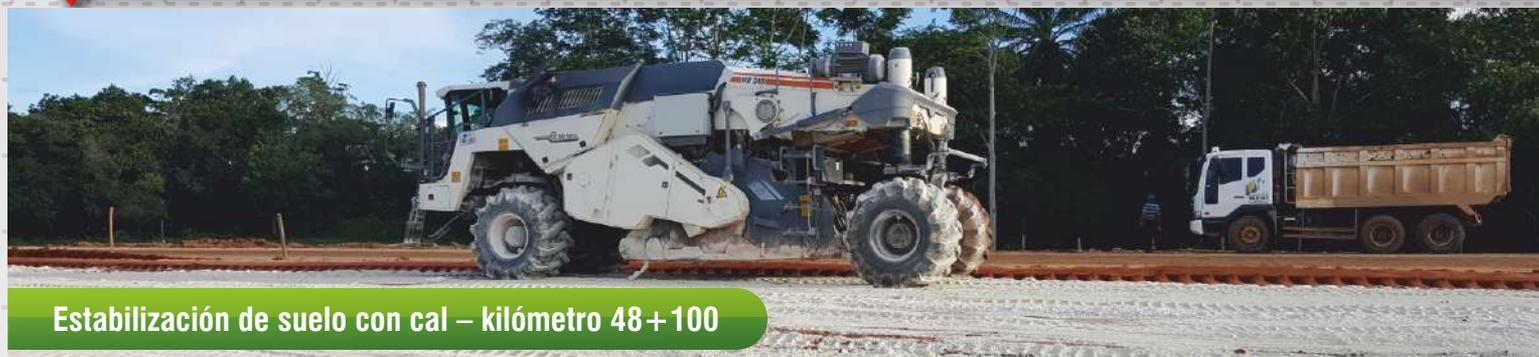
Estabilización de suelo con cal – kilómetro 48+100
